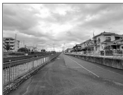
防草マット 敷設完了
