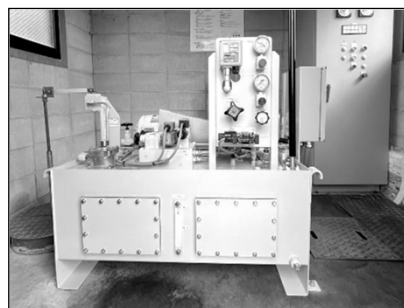
転倒堰 油圧ユニット 更新完了
