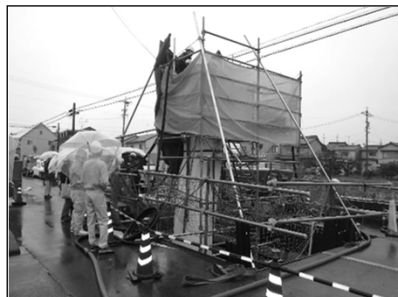
管更生 施行状況
