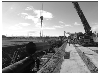
管水路 布設状況
