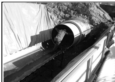
管水路 布設状況
