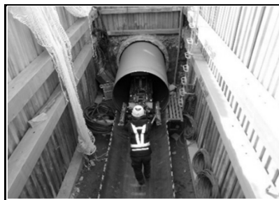
管更生 施行状況
